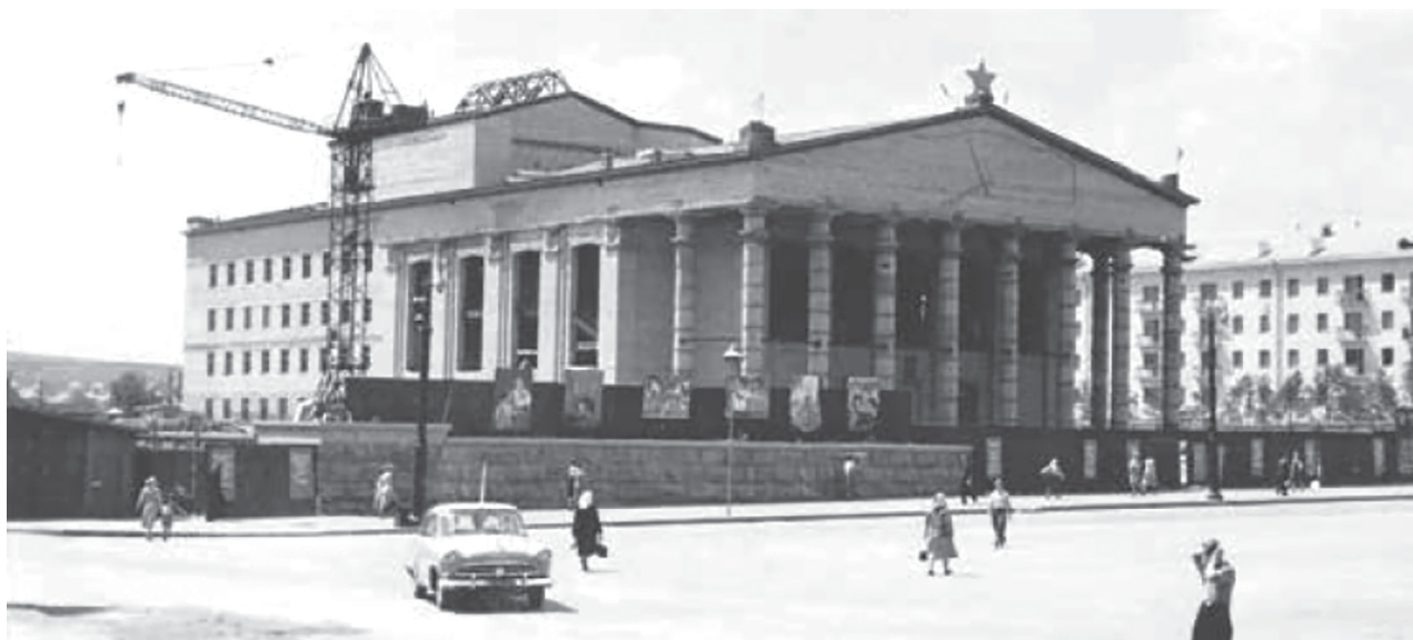
Рис. 6. Белгородский драмтеатр на завершающей стадии строительства, начало 1960-х гг. Автор неизвестен
