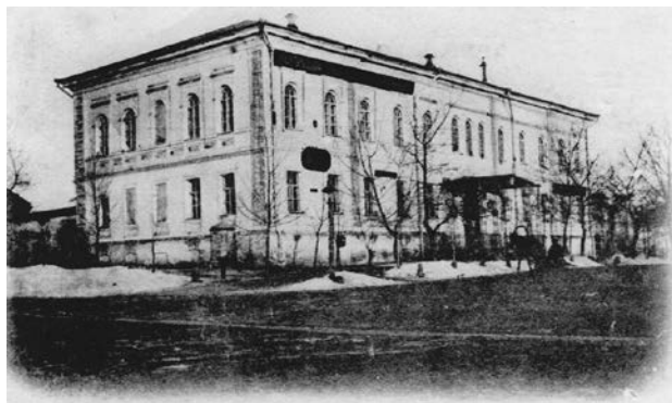
Рис. 4. Здание городской управы, 1904 г. Автор не известен
