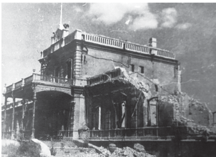
Рис. 8. Разрушенное здание вокзала, 1943 г. Фотография из фондов ГАБО. Автор неизвестен
