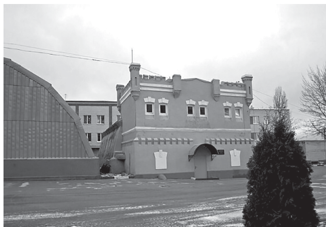
Рис. 1. Здание водонапорного бака на ул. III Интернационала в г. Белгороде
