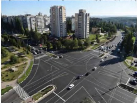
Рис. 8. Реконструированный перекресток на ул. Губкина – пр. Ватутина
