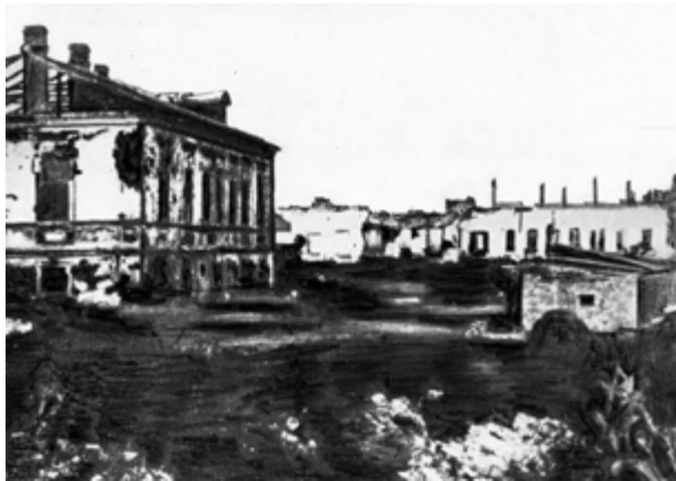
Рис. 6. Здание железнодорожной поликлиники. Белгород, 1943 г. Автор неизвестен
